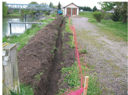
Ouverture de la tranchée "coffrets électriques"
