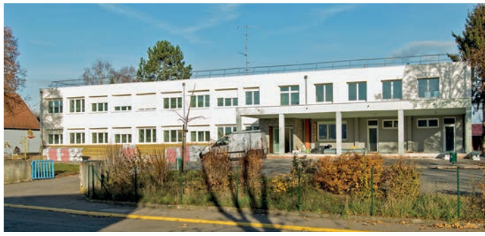
Photos du chantier fin novembre
